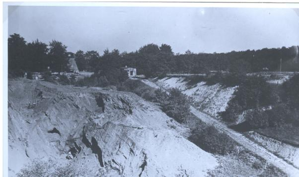
Zu Beginn der Erzförderung wurden die Lager in Tagebauen ausgebeutet. Ab einer bestimmten Tiefe war das nicht mehr möglich, sodass in allen Gruben Schächte abgeteuft werden mussten.
