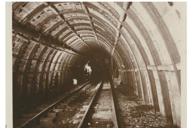
Bis ca. Mitte 1950 wurden die aufbereiteten Erze der Grube Morgenstern mit einer Erzseilbahn zur Grube Fortuna befördert. Da die Standsicherheit der Seilbahnmasten durch die Nähe zum Fortunabruchfeld nicht mehr gewährleistet war, wurde eine untertägige Verbindungsstrecke aufgeföhrt. Bis zur Schließung der Gruben 1963 wurden so die Roherze per Grubenbahn zur Aufbereitung Fortuna transportiert.
